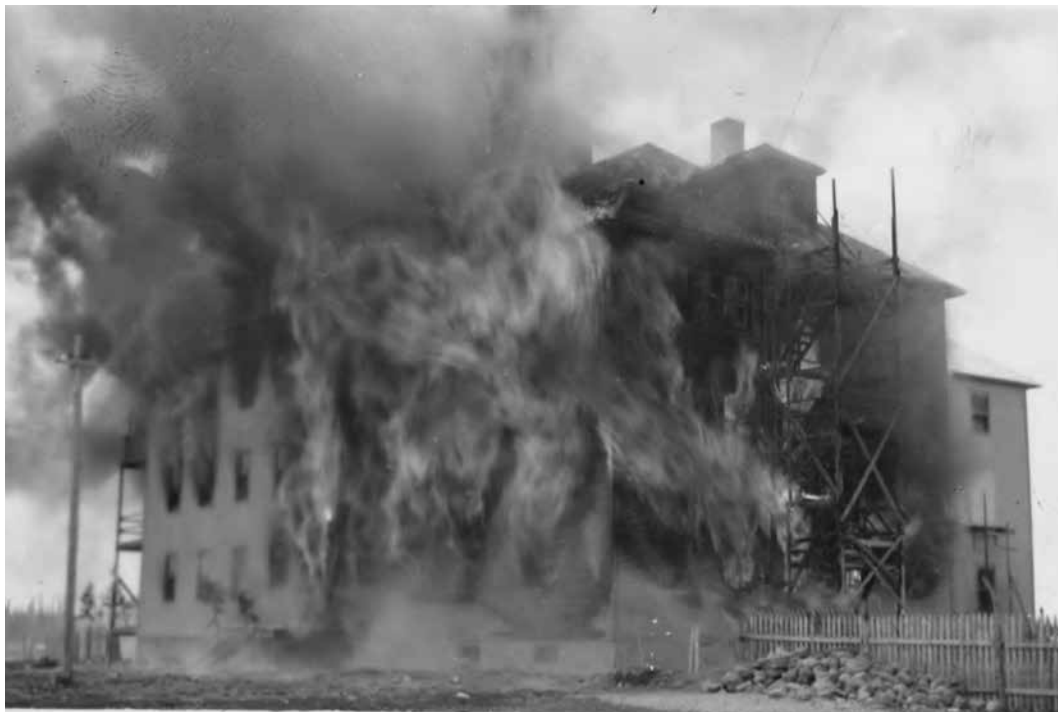
Un incendie pouvait se propager rapidement dans les bâtiments à ossature en bois qui disposaient de très peu de protection contre les incendies. Sur la photographie du haut, l'incendie qui a détruit l'école Norway House, au Manitoba, en 1913. Sur la photo du bas, l'incendie qui a détruit l'école de Fort Albany, en Ontario, en 1939. Musée Glenbow, NA-2749-24; Archives Deschâtelets.
