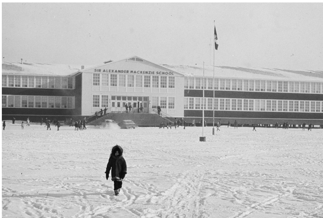
L'extérieur de l'école Sir Alexander Mackenzie à Inuvik, dans les Territoires du Nord-Ouest, en avril 1970. L'école avait deux ailes distinctes : une catholique, l'autre protestante. Ministère des Travaux publics et des Services, Archives des Territoires du Nord-Ouest, Wilkinson, N-1979-051 : 0409S.
